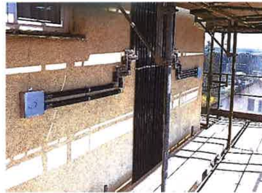
Rénovation Immeuble locatif à Gland en passant les tubes de pulsion du double flux en façade sans créer de pont thermique grâce à leur faible diamètre de 47mm
